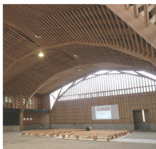
北沢建築工場棟・稲山正弘
